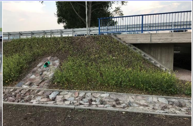
Flügel Südwest mit Auslauf für Entwässerung
